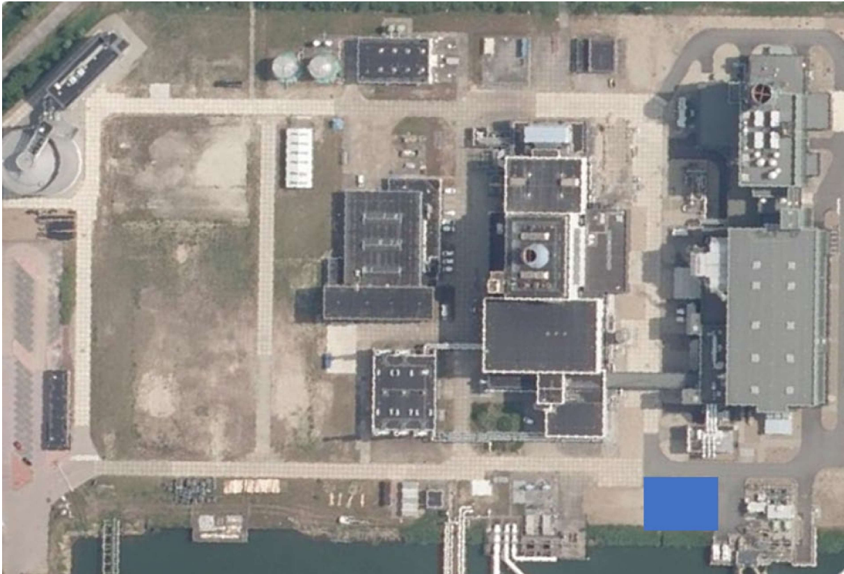
Figuur 2. Globale positie van het e-boilersysteem binnen de inrichting
