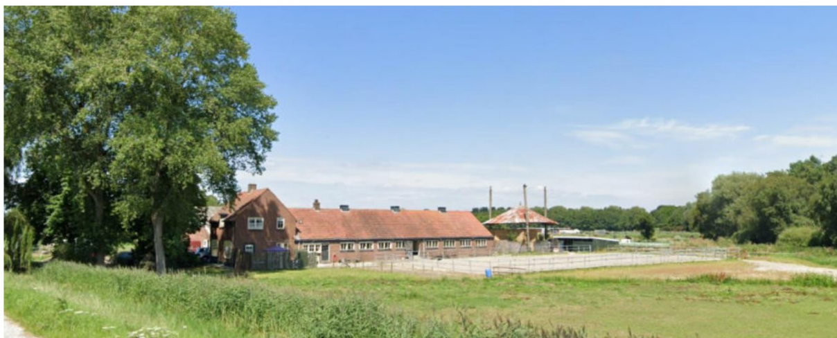
Figuur 4b. Aanzicht september 2020 (Google Street View)
