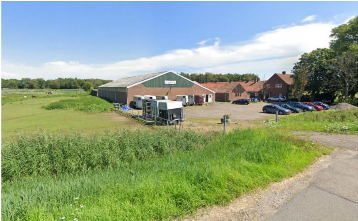
Figuur 5. Noord aanzicht Stal Stammerdijk vanaf de dijk met rijhal, stallen, woning en parkeerplaatsen (Bron: Google Street View)
